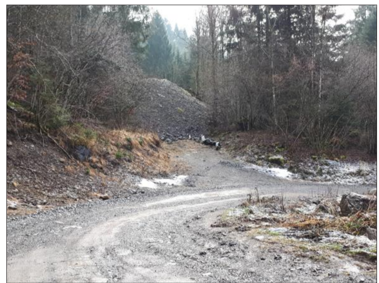
La noria de camions venue déverser des milliers de mètres cubes de déchets de façon sauvage a contribué à dégrader le chemin communal, aujourd'hui défoncé. Au centre de l'image, un aperçu du monticule de déchets. Photo Le DLV/B.
