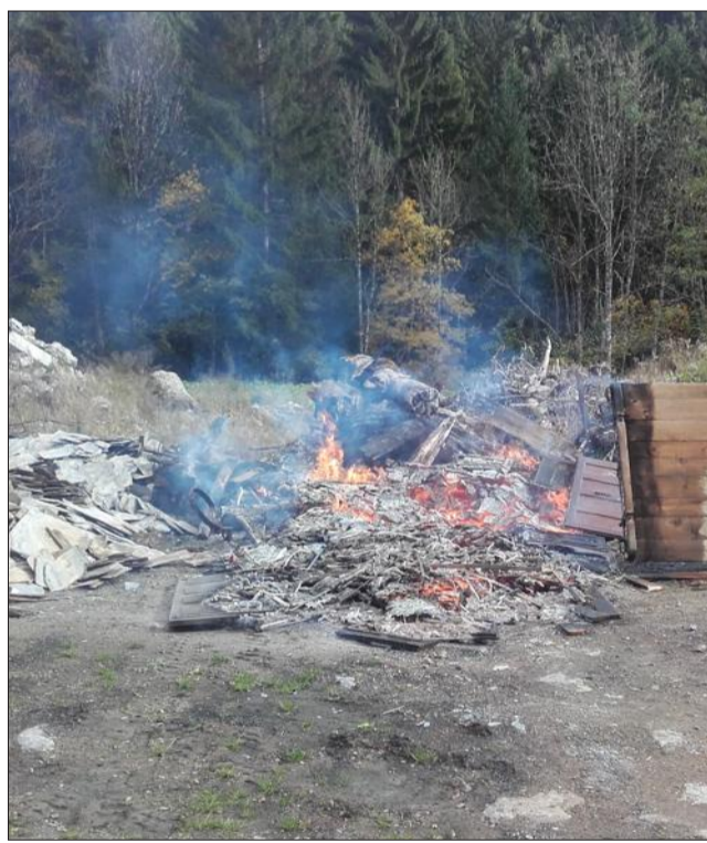
Des matériaux issus de démolitions ont parfois été incendiés. Comme ici, à l'automne 2016. Photo DR.
